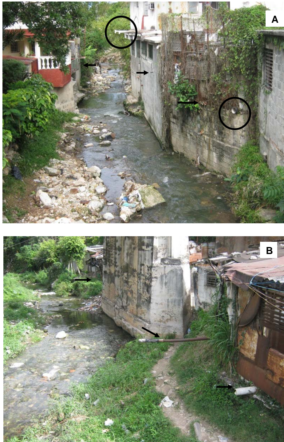
Figura 6. Vertimientos de aguas residuales domésticas que se realizan directamente al río Quibú en la comunidad Los Pocitos provenientes de viviendas ubicadas en las riberas del río. Las flechas y círculos indican los lugares exactos de vertimientos desde las casas.
